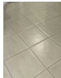
(2) PAVIMENTO CERÁMICO EXISTENTE RECUPERADAS LAS JUNTAS ENTRE PIEZAS RODAPIES Y APLICADAS PLETINAS ENTRE CAMBIOS PAVIMENTOS
