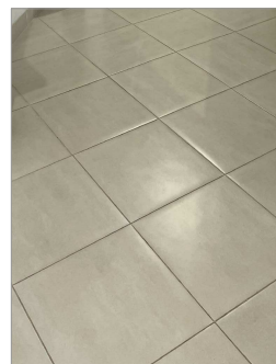
(2)PAVIMENTO CERÁMICO EXISTENTE RECUPERADAS LAS JUNTAS ENTRE PIEZAS RODAPIES Y APLICADAS PLETINAS ENTRE CAMBIOS PAVIMENTOS
